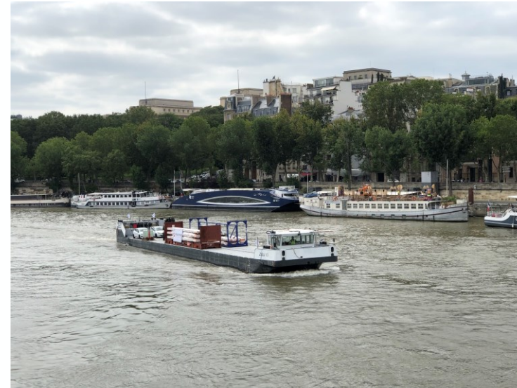
Chantier réalisé par Poulingue.
