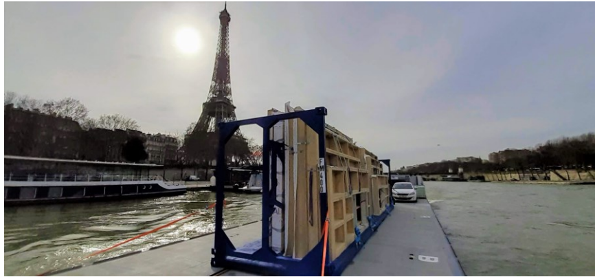
Chantier réalisé par Cuiller Frères.
