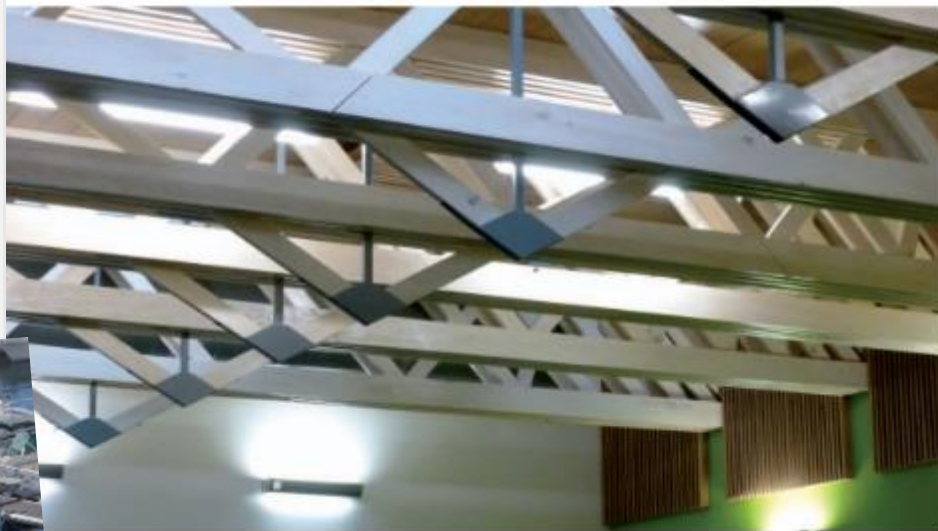
Spécialement dessinés par les architectes, des panneaux acoustiques en fibre de verre sont disposés à des entrées précises afin d'assurer la meilleure absorption possible du son.
