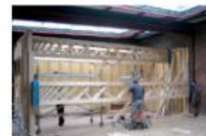
Une « boîte » composée de modules de murs à ossature bois de 140 cm x 60 cm soutient les poutres et s'insère dans l'enveloppe de briques existante.
