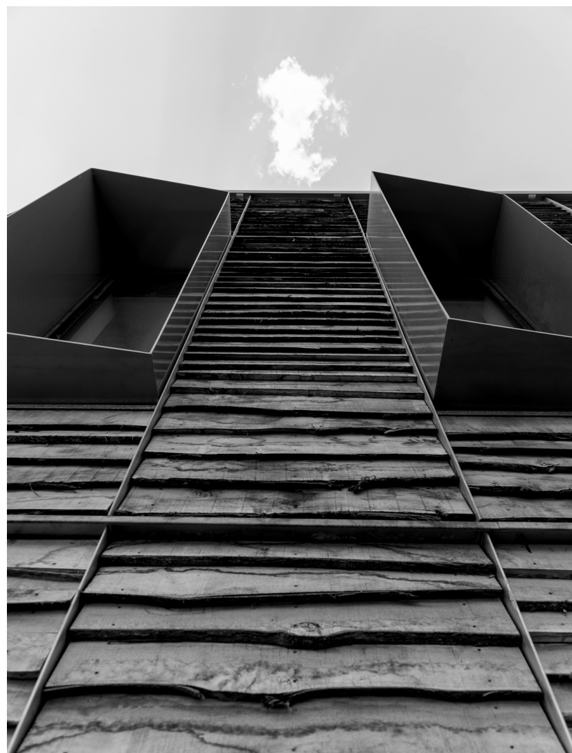
Cité scolaire, Tourny – Agence d'architecture MWAH – Crédit photo A&S photographes –
