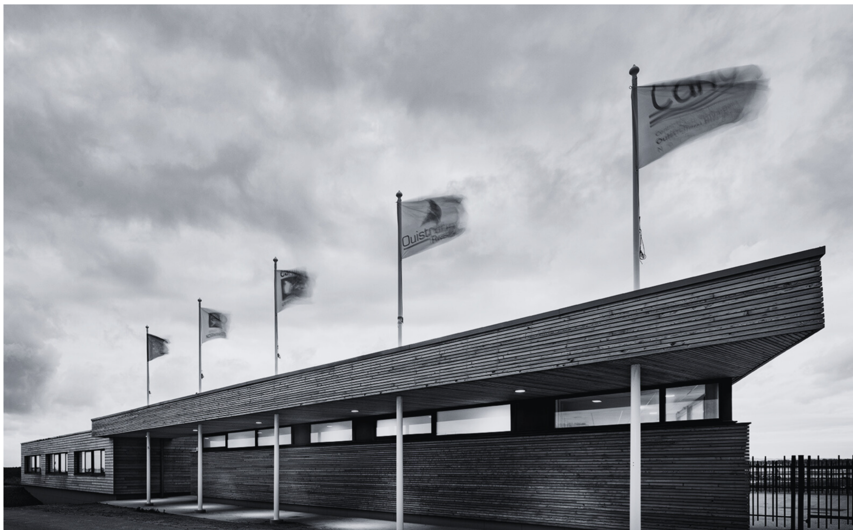
Centre d'activités nautiques, Ouistreham – Agence d'architecture JVA Architectures et associés – Crédit photo Guillaume Jouet
