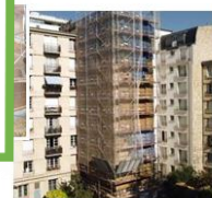
Bottes fixées par sangles sur mur maçonné, ParisHabitat, 2021
