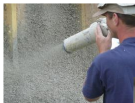
Projection de chanvre-chaux, ou mieux, de chanvre-terre
