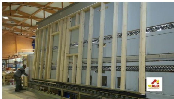
Préfabrication de mur en atelier
