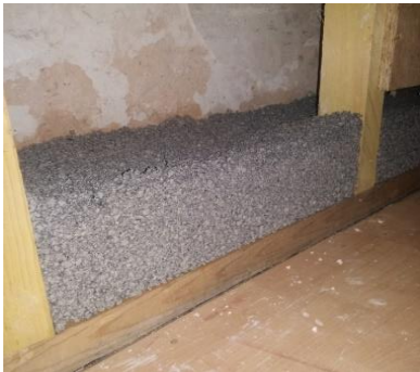
Béton isolant chaux/billes de liège expansé. Mylène Gajic
