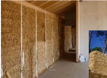
Murs en bottes de paille port Twiza
