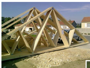
Charpente par fermettes
