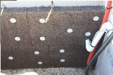
Panneaux de liège expansé en sol ... et en isolation d'un mur enterré (ici en attente de protection)
