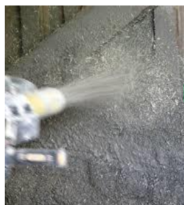
Projection de chanvre-chaux, ou mieux, de chanvre-terre
