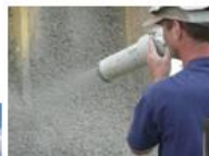
Projection de chanvre-chaux, ou mieux, de chanvre-terre
