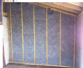
Ouate de cellulose projetée sur mur pisé
