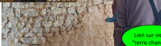
Mélange chanvre-terre projeté. EcoPertica
