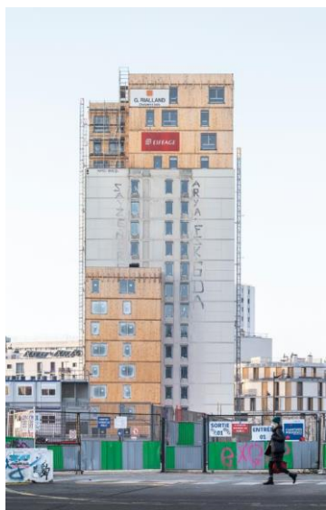
Tour Watt (Paris). Vincent Lavergne Architecture et A&B PMCR Extension et surélévation en bois en BS
