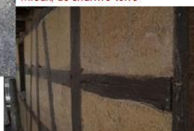
Projection de chanvre-chaux, ou mieux, de chanvre-terre
