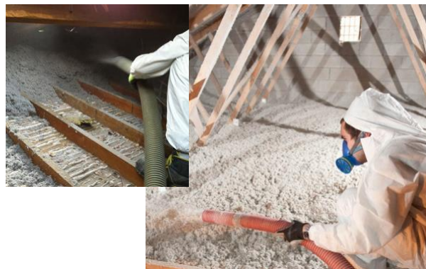
Ouate de cellulose - Mise en œuvre sèche ou humide
