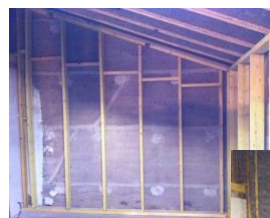
Ouate de cellulose projetée sur mur pisé
