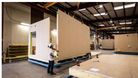
Préfabrication de modules tridimensionnels
