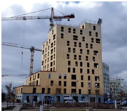
Résidentiel Strasbourg, 2018 - 11 étages ASP Architecture + KOZ Architecte Ossature CLT, ITE paille
