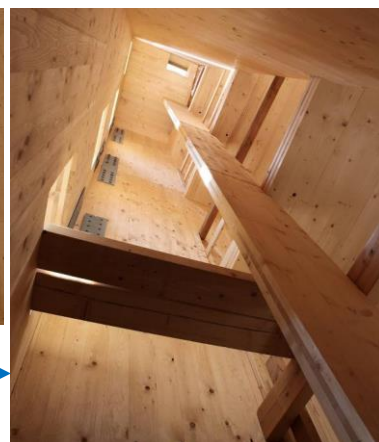
Panneaux contrecollés et CLT (panneau massif lamellé croisé) peuvent selon leur épaisseur et le type de bâtiment représenter le parement intérieur tout en assurant une fonction structurelle.
