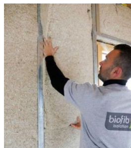
Certains proposent des mélanges de fibres. Ici Biofib trio (Chanvre, lin et coton recyclé). BIOFIB®
