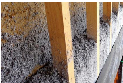
Ouate de cellulose projetée humide
