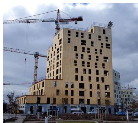
En cours de chantier
