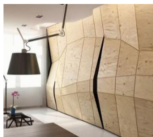
Le contreplaqué, en exemple de panneau pouvant rester apparent.
