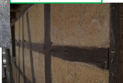
Projection de chanvre-chaux, ou mieux, de chanvre-terre
