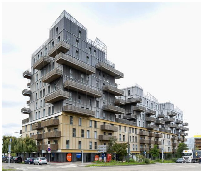
Résidentiel Strasbourg, 2018 - 11 étages, 142 logements ASP Architecture + KOZ Architecte Ossature CLT, ITE paille
