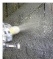
Projection de chanvre-chaux, ou mieux, de chanvre-terre
