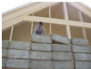
Chantier exp. de Montholier (39) FFB/ADEME, 2002
